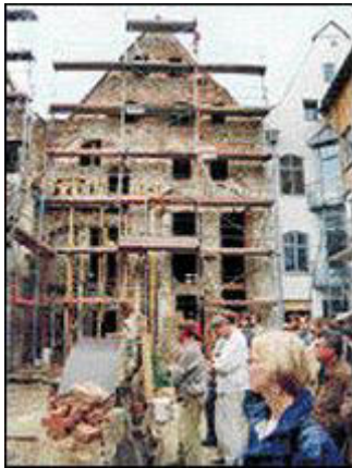
Richtfest wurde gestern in der Frankenstraße 31/32 gefeiert.
